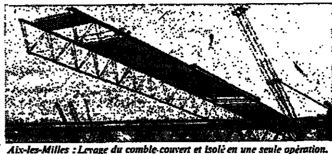
Aix-les-Milles : Levage du comble couvert et isolé en une seule opération.
